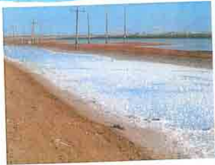
DAMPIER SALT FLATS
